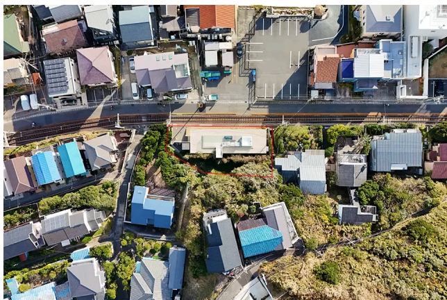
真上から（赤枠内：敷地）
