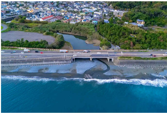
敷地を南側から
