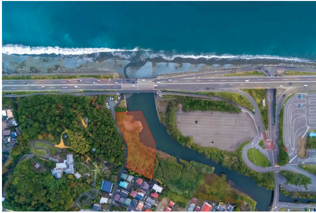
真上から（赤枠内：敷地）
