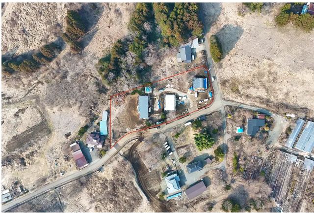
真上から（赤枠内：敷地、工事中）
