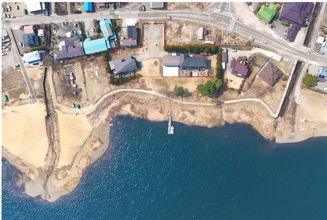
真上から（赤枠内：敷地）
