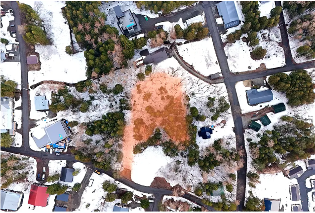
真上から（オレンジ部分：敷地）
