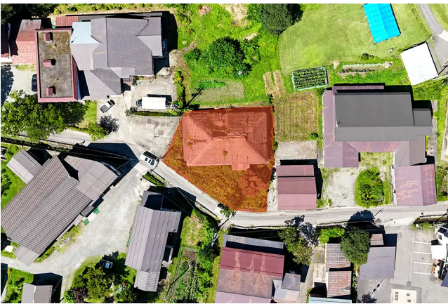
真上から（オレンジ部分：敷地）
