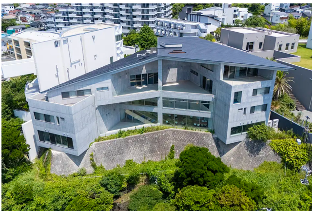
西側（海側）からの外観
